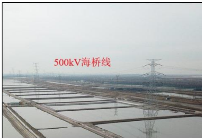
图 3.1-1 并行现状 500kV 海桥线航拍照片
