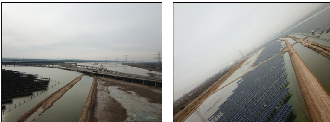
图 3.1-2 本项目占地现状航拍照片
