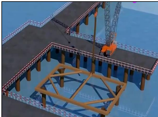
图 3.1-6 插打第一片钢板桩
