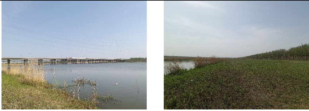
图 3-4 永定新河河滨岸带生态保护红线现场照片
